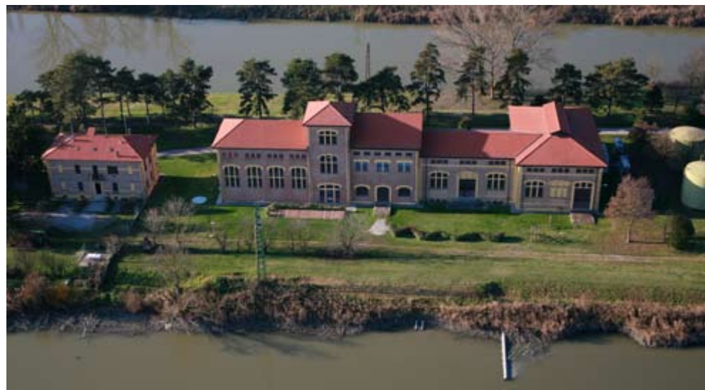
Impianto Idrovoro di Saiarino
